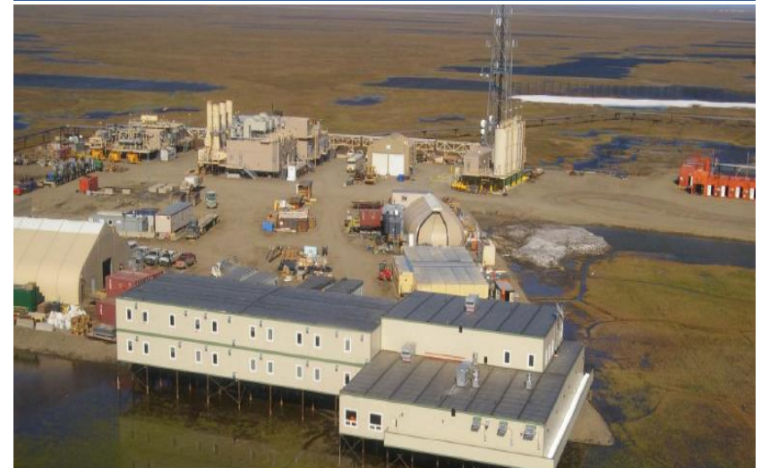
Oooguruk Tie-In Pad (OTP)
